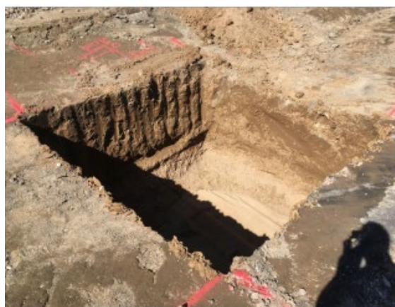
Fosse pour cuve de 15 000 litres enterrée dans le sol pour arroser les plantes de la cour avec les eaux pluviales
