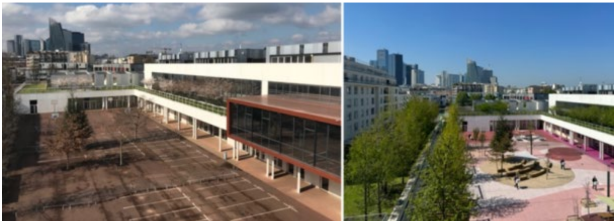
Végétalisation des espaces extérieurs du collège G. Pompidou de Courbevoie - avant/après (mars 2021/mars 2023)
