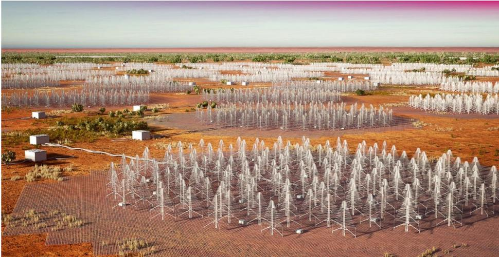
À l'issue de la phase SKA1 (dite « *Design baseline* »), ce réseau « basses fréquences » devrait comporter 131 072 antennes. La distance inter-antennes maximale – ce qui constitue un facteur très important en interférométrie pour la qualité de la résolution obtenue - atteindra 150 km.
