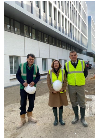
Visite de chantier du siège de la DRSD au Fort de Vanves
