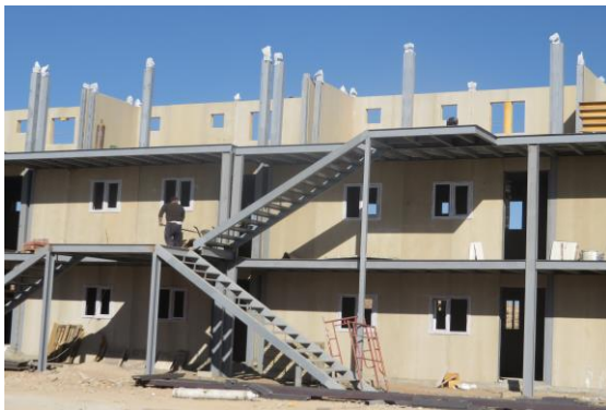
Constructions dans un camp de réfugiés
