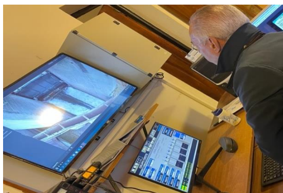
M. Victorin LUREL observe le système de contrôle d'alimentation en eau de la digue Cipolletti
