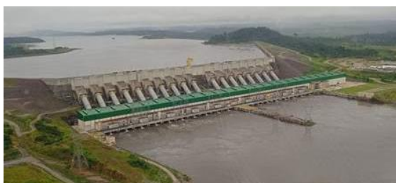
A barragem hidroelétrica de Belo Monte, na Volta Grande do Rio Xingu, em Altamira
